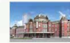
⑩東京駅丸の内駅舎保存 ・復原工事
